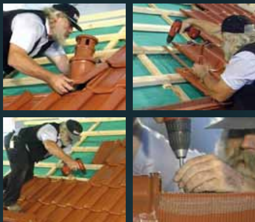
Ежи Птак во время укладки черепицы
